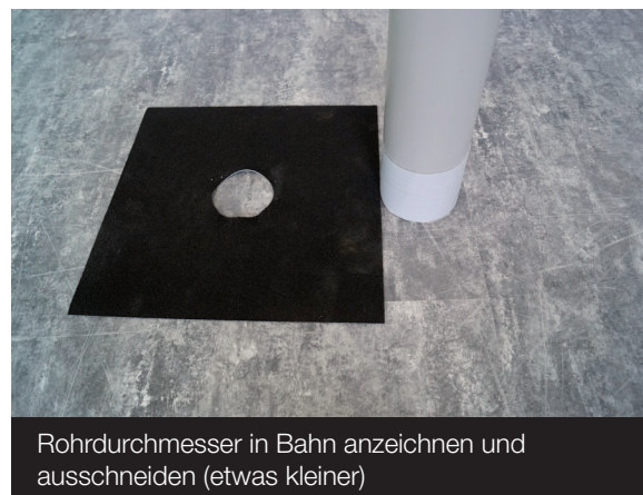
Doppelseitiges Butylband um Rohr kleben
